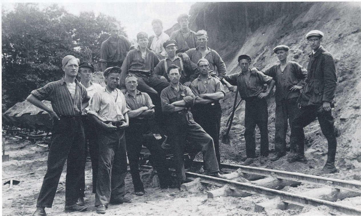
Arbetare vid grusschakt på flygfältet, omkr 1935. Foto Gustav Andersson.
